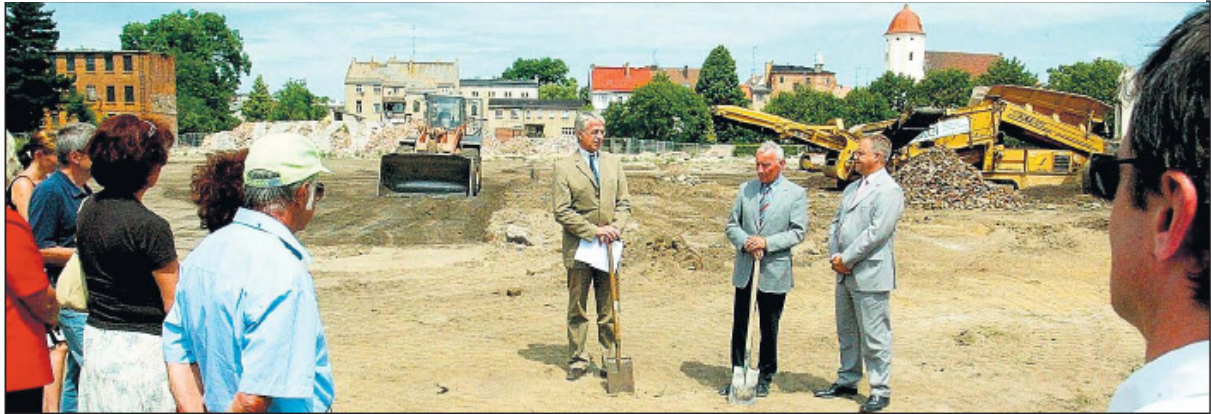
Dieses Areal hat den Finsterwalder Stadtvätern viele Jahre Kopfzerbrechen bereitet: Gestern begannen die Bauarbeiten für ein neues Altenpflegeheim zumindest symbolisch. Foto: Dieter Saida
